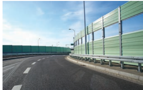
S protihrupnimi ograjami preprečujemo škodljive posledice hrupa vozil.
